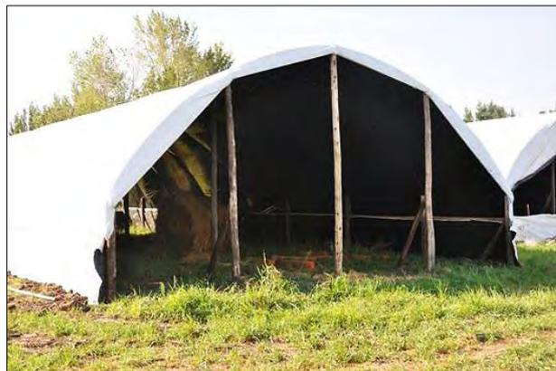
“La estructura tiene un largo máximo de 22 metros con un ancho de 8 metros y 4 metros de alto en el parte central, para lograr una óptima ventilación del túnel. La superficie asignada por animal debe ser de 1,4 metros cuadrados, con la premisa de no superar los 120 a 130 animales a engordar por galpón. El costo calculado por metro cuadrado, incluida la mano de obra y materiales, varía entre \$70 y \$100 por plaza de engorde”, explicó Franco.
