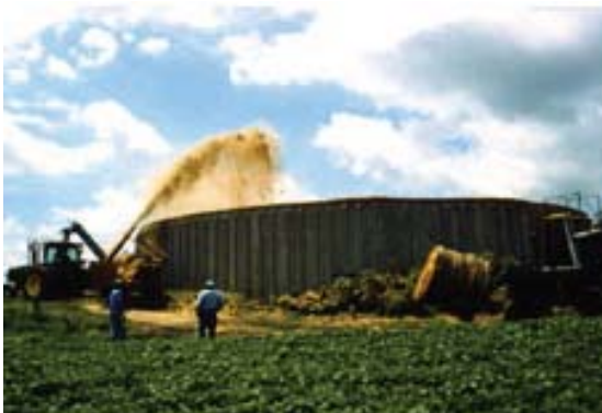
Figura 3. Distribución de paja picada sobre la superficie de una balsa cilíndrica de almacenamiento de purín.
