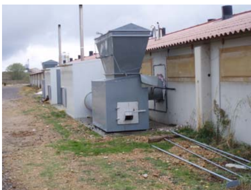
Figura 10. Elementos de control ambiental. Izquierda: estufa de biomasa. Derecha: ventilador con sistema de refrigeración cooling.
