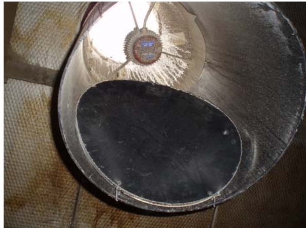
Figura 9. Chimenea de ventilación
