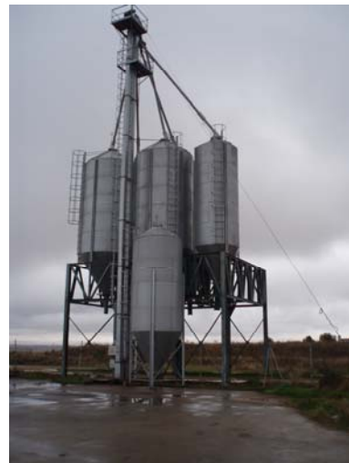
Figura 3. Silos exteriores de recepción de pienso
