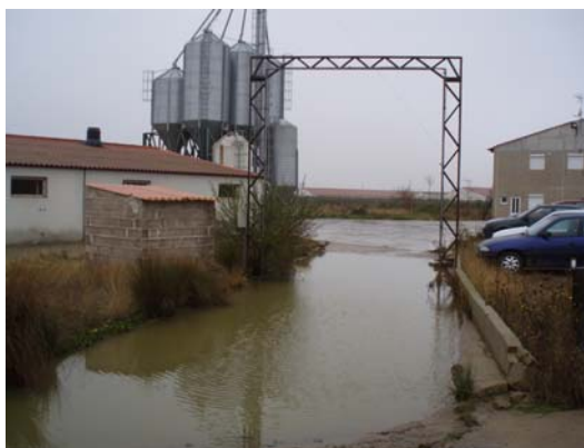
Figura 2. Vado sanitario y arco de desinfección.
