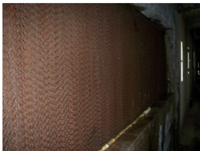
Maternidad con panel humificador y extractores – Sáenz Peña - Chaco.
