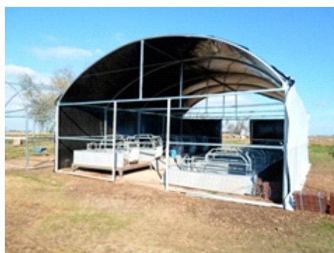
Maternidad con techo hierro estructural y cobertura de plástico, piso cemento - Marcos Juárez.
