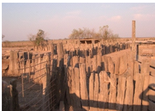
Corral tradicional del norte con palos a pique de quebracho colorado – Charata - Chaco.
