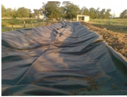
Geomembrana para tratamiento de efluentes - Las Breñas.
