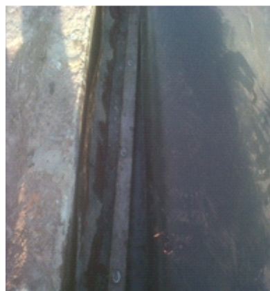
Sistema de anclaje de geomembrana.
