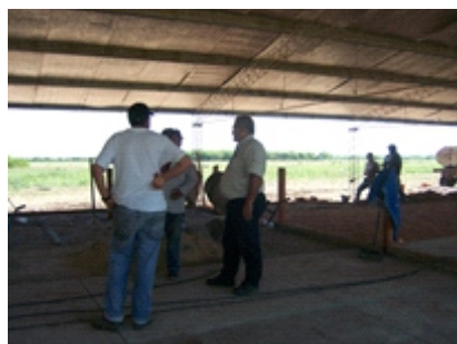
Pista de terminación en construcción.
