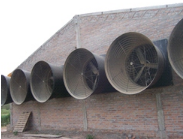
Sistema de ventilación forzada en galpón de engorde - Sáenz Peña, Chaco.
