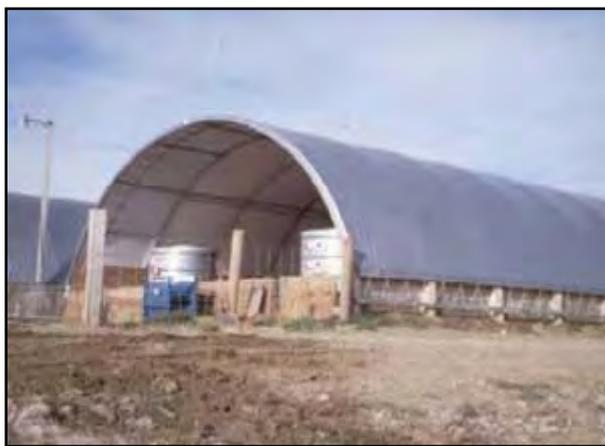
Fig. 2.- Hoop para recría terminación (USA) El túnel más típico tiene un largo de 22-24 m con un ancho de 9 m.
