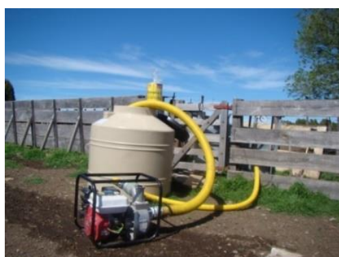
Recipiente y bomba de inyección
