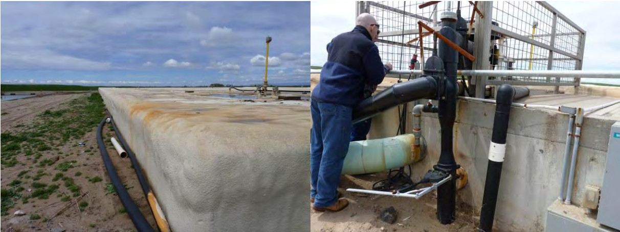
Digestor de hormigón muy simple
