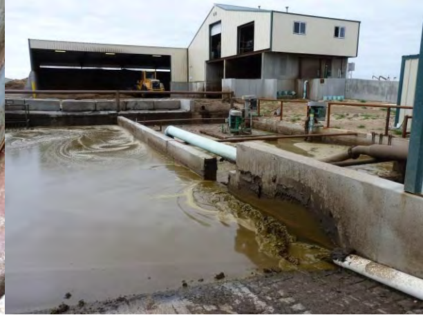
Sector de recepción y mezclado de estiércol
