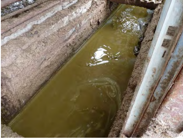
Fosas ubicadas en los extremos de los galpones
