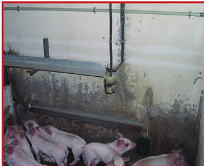
Figura 3. El pH del agua es un parámetro a tener en cuenta en la cloración del agua.
