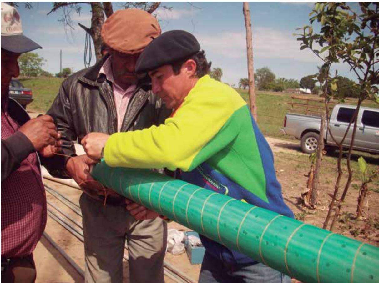
Armado de filtro para las perforaciones Paraje Buena Vista, Goya, Corrientes.
