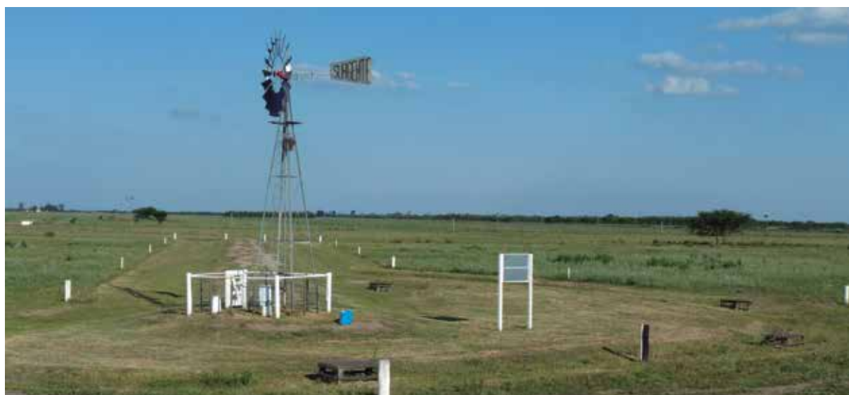
Unidad “La Gueya”: Sistema de pata de araña compuesto por molino y cuatro perforaciones. Se aprecia la sistematización de caminos.
