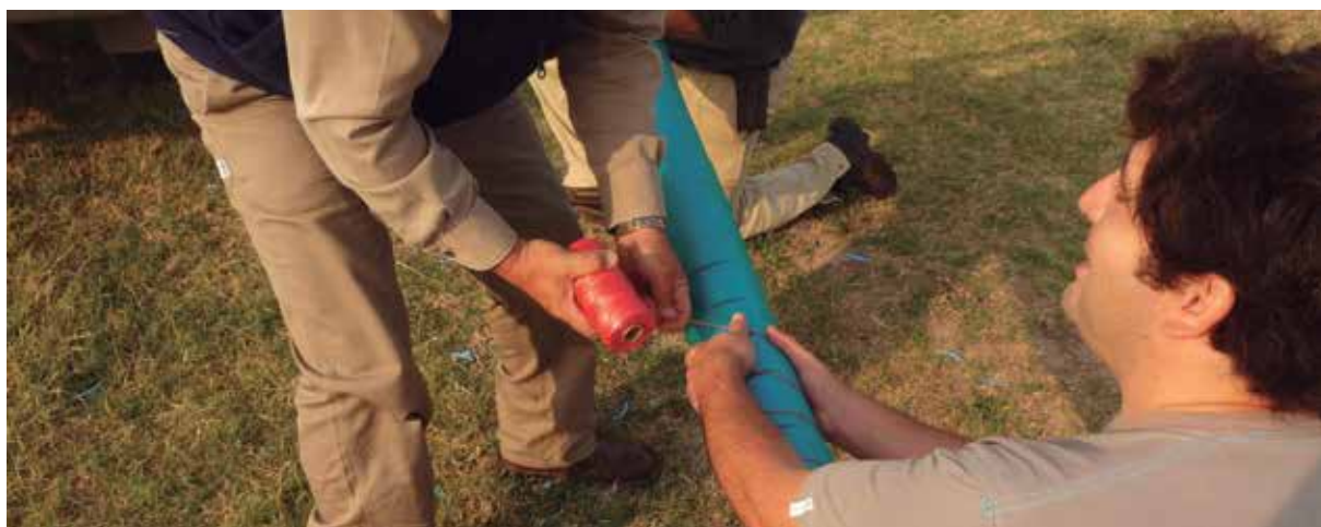
Unidad "Dos Hermanos": armado de filtros artesanales acordes a granulometría del lugar.
