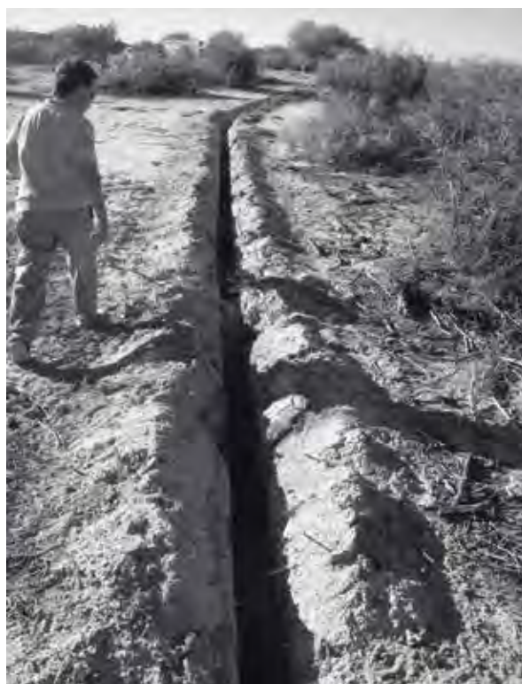
Avance de la obra de acueducto.
