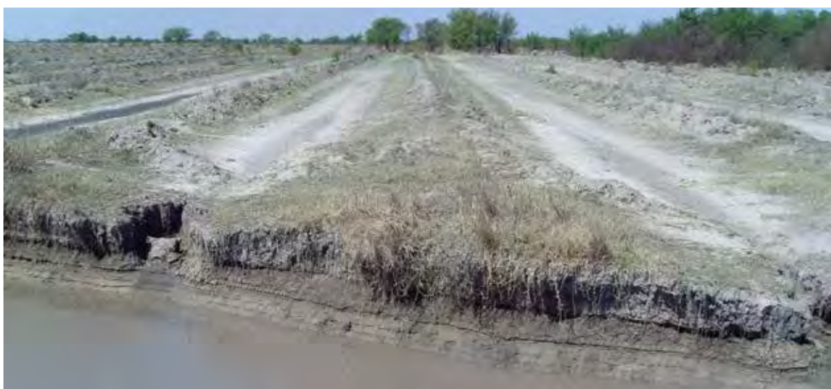
Unidad "Las Patricias": Superficie de captación o cosecha del agua de lluvia (camellones) y decantador.
