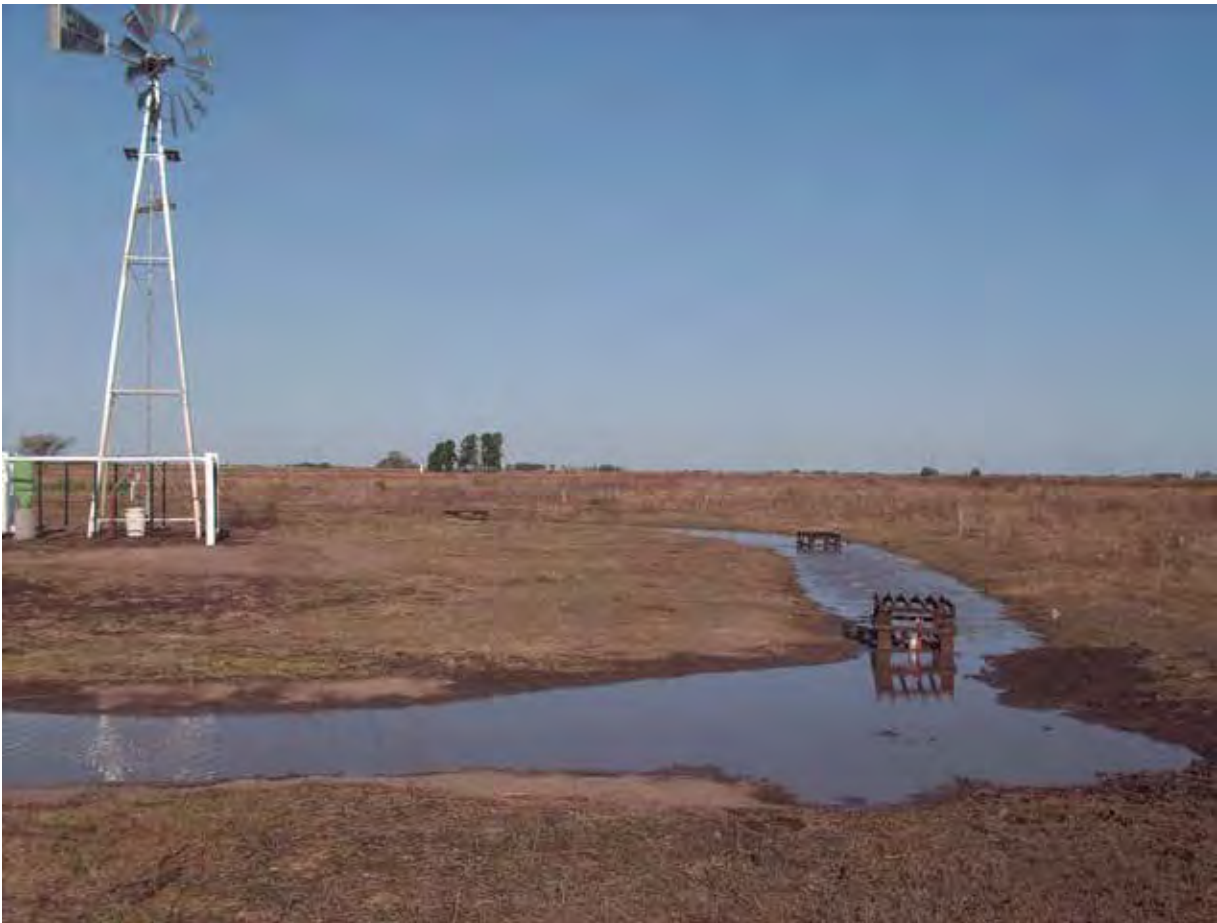
Sistema de recarga de acuíferos. La foto fue tomada después de una lluvia. Se aprecia la acumulación de agua y la recarga del acuífero inducida por la sistematización del terreno y realizada a través de los filtros de arena de las perforaciones doble propósito.
