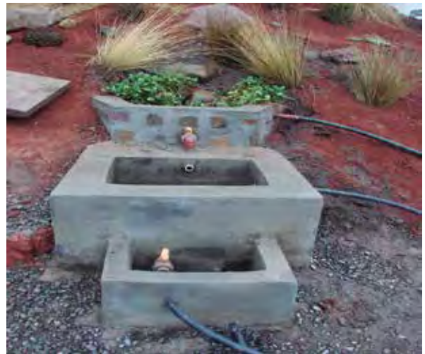
Izquierda: Cámara de carga que recibe los caudales de la captación de manantial concentrado (al fondo). Derecha: cámara de carga adyacente a la captación del manantial de ladera. También cuenta con una cámara seca, la más pequeña, que protege la válvula de salida.
