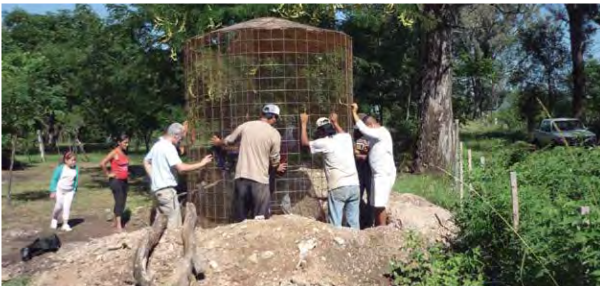
Construcción de reservorio de ferrocemento en la localidad de Anisacate.
