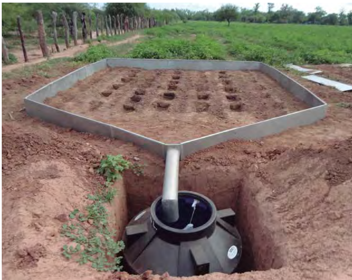
Implementación del tratamiento de surco truncado.
