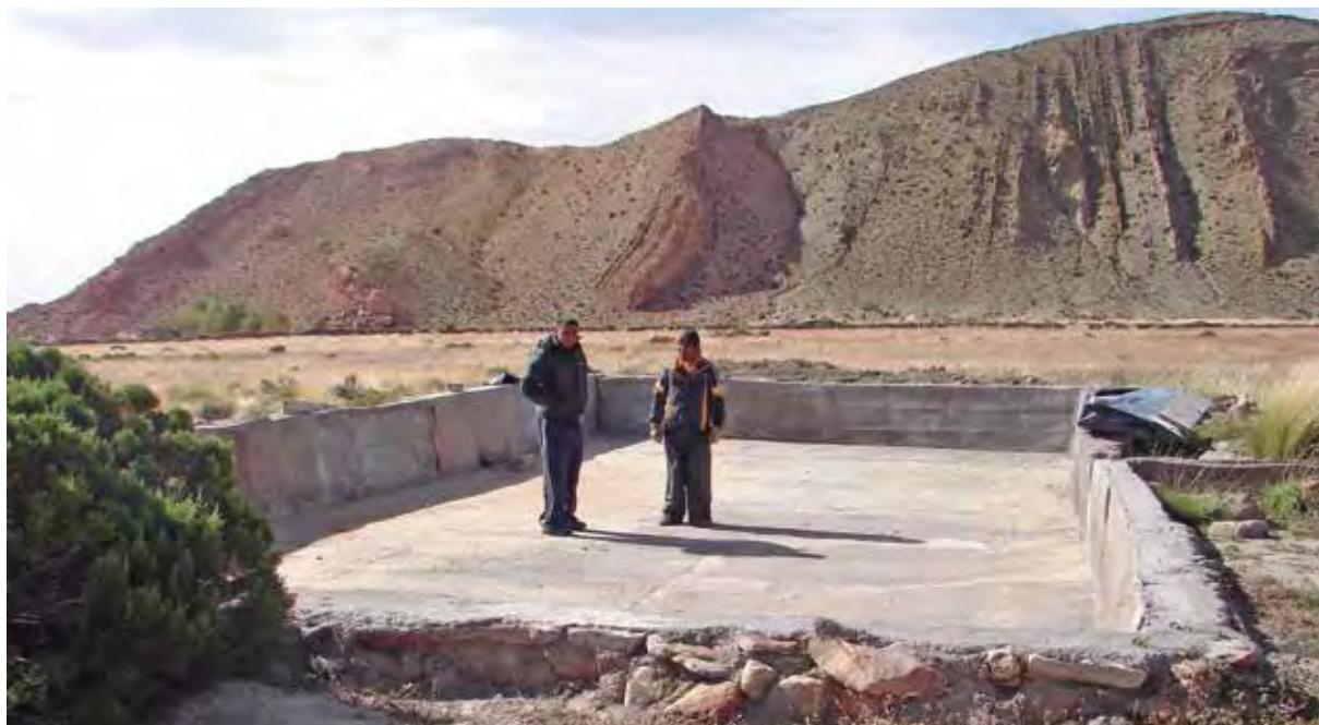
Construcción de represa comunitaria de hormigón en San José del Chañi.
