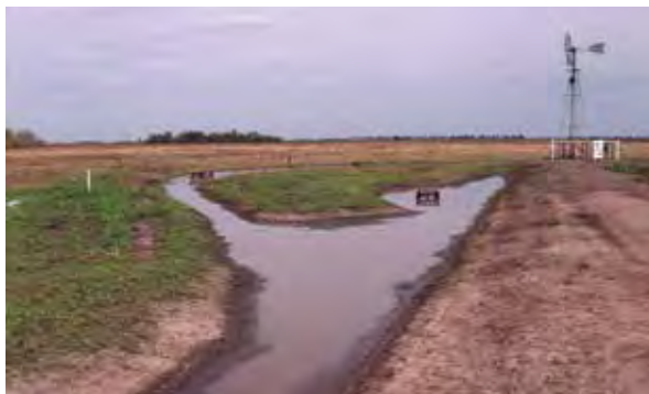
Vista general del sistema de recarga de acuíferos. Se aprecia el efecto del camino de doble propósito que facilita la conducción del agua hacia la zona de recarga. Facilitando la incorporación del agua de lluvia al sistema se contribuye a diluir los contenidos en exceso de sales de la napa freática.
