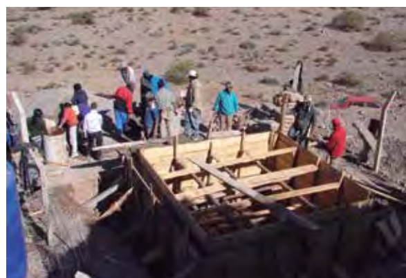
Construcción de cisterna.
