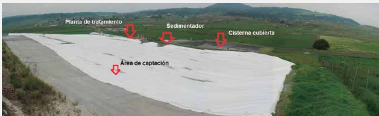
Componentes del sistema SCALL de la comunidad Mazahua (México). Fuente: M. Basan Nickisch y R. Tosolini (2015).
