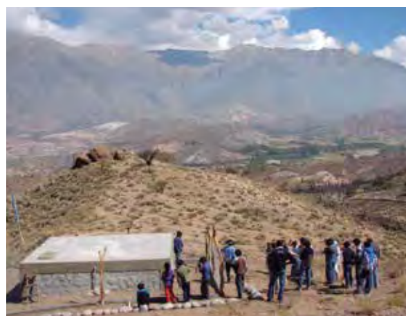
Cisternas de hormigón.
