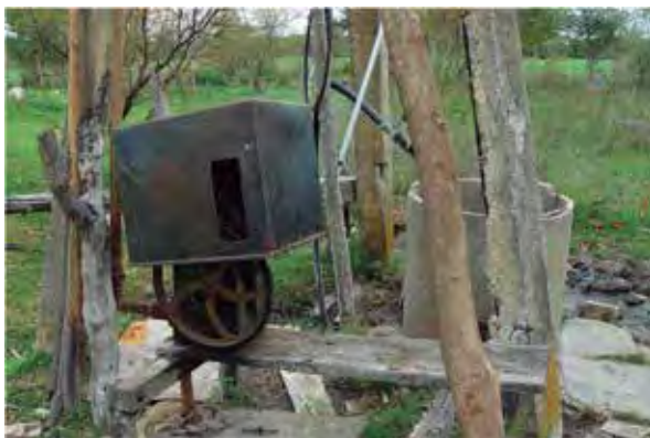
Infraestructuras de captación y almacenamiento precarias u obsoletas. (Fotografía de Pauline Moulinier).
