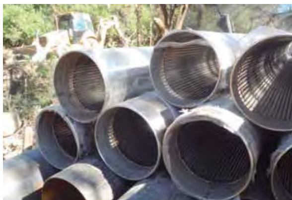
Cañerías y filtros empleados en la obra. Foto: Juan Pablo Zamora Gómez.
