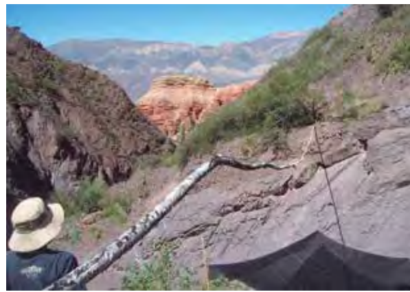
Cruce especial de tubería en una quebrada.
