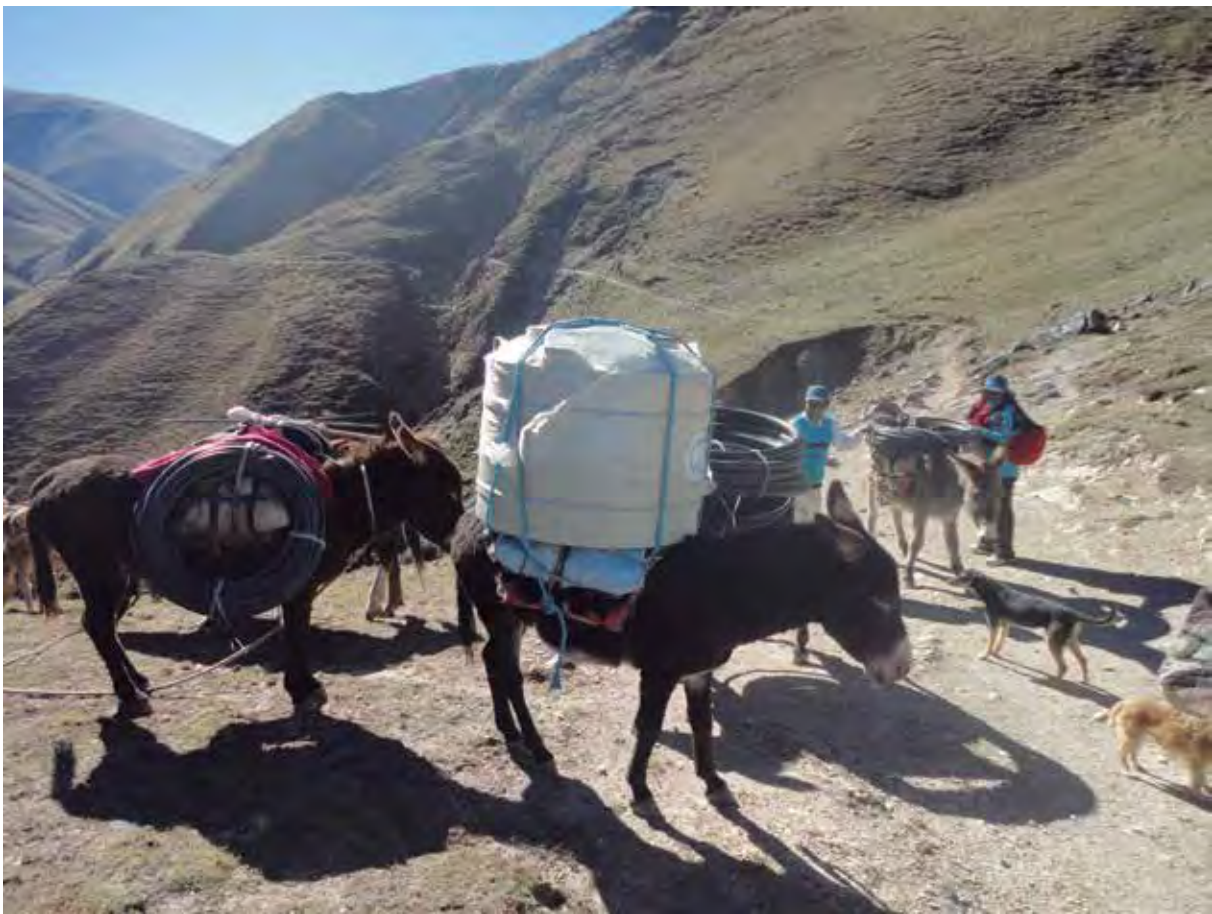
Traslado de materiales durante ocho horas de camino a los Valles de Altura. Obras hídricas familiares de la Comunidad Aborigen de Las Ánimas. Departamento Tilcara, Quebrada de Humahuaca, Jujuy.
