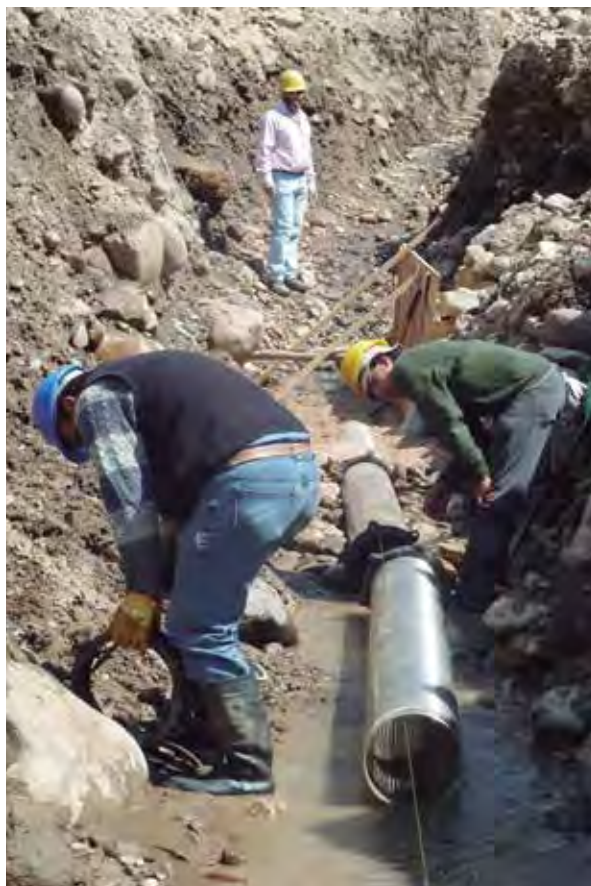
Instalación de filtros de acero inoxidable.
