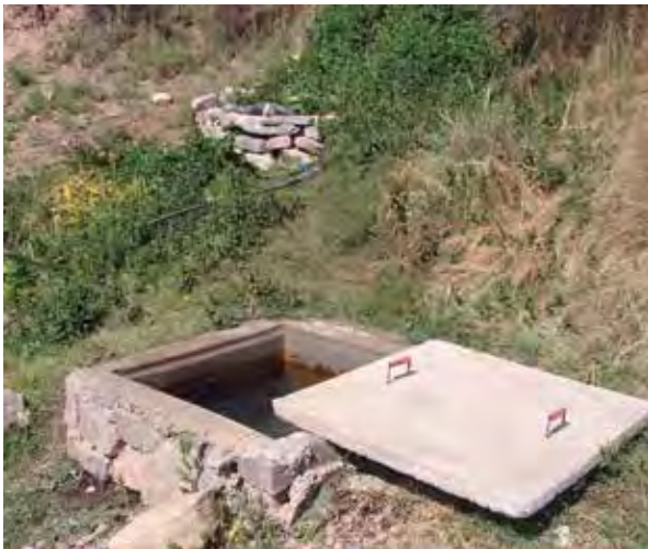
Izquierda: Cámara de carga que recibe los caudales de la captación de manantial concentrado (al fondo). Derecha: cámara de carga adyacente a la captación del manantial de ladera. También cuenta con una cámara seca, la más pequeña, que protege la válvula de salida.
