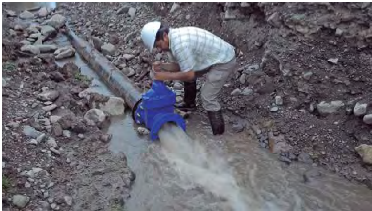
Producción de agua subterránea por gravedad.
