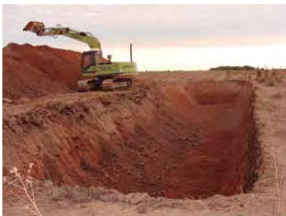
Construcción de represa en Villa Minetti.
