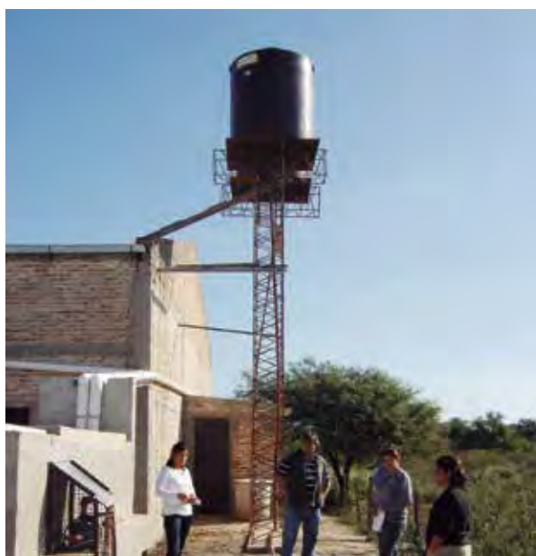
Aljibe comunitario de 100.000 litros y tanques de 5.000 litros cada uno en el predio de la Asociación Vecinal.
