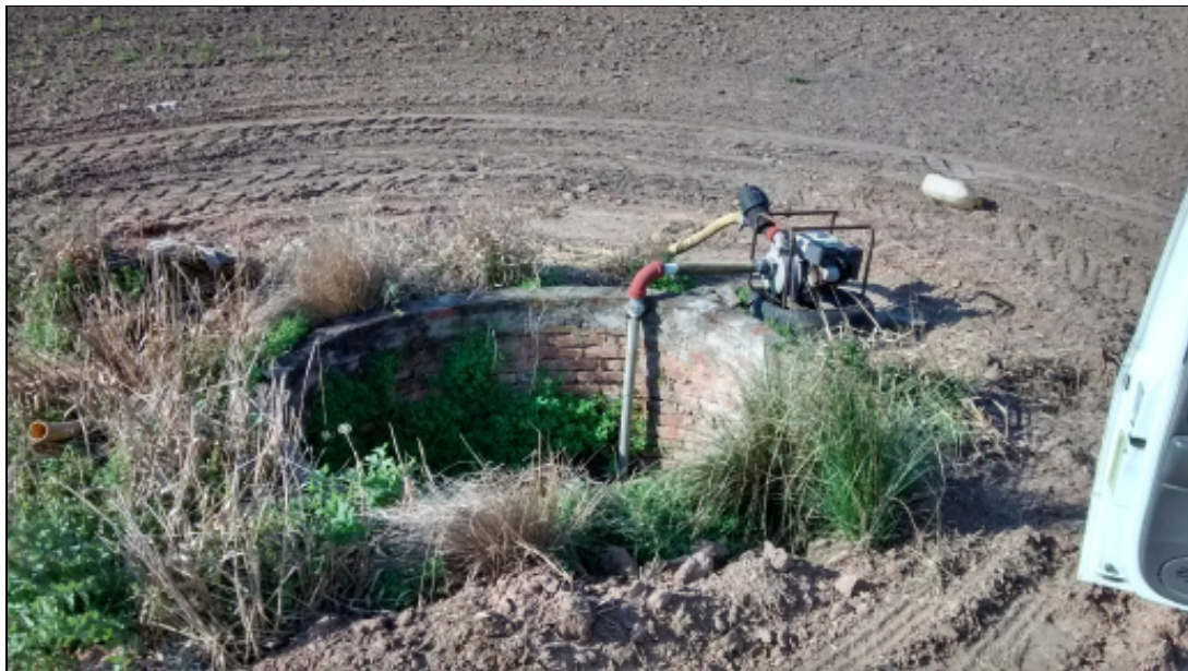
Pozo calzado con motobomba con brocal bajo y sin tapa.
