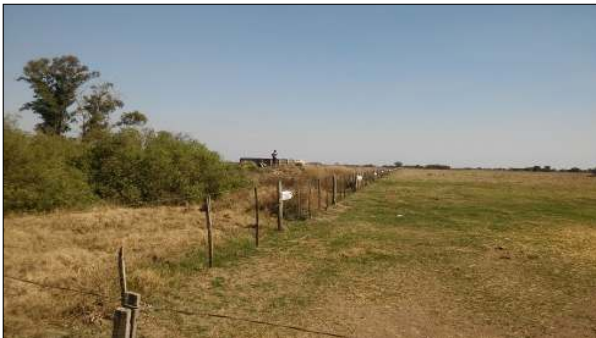
Tanque australiano sobreelevado, sin funcionar, con problemas de pérdidas de agua, que se debe reacondicionar y el cual nunca es conveniente que quede sin agua.
