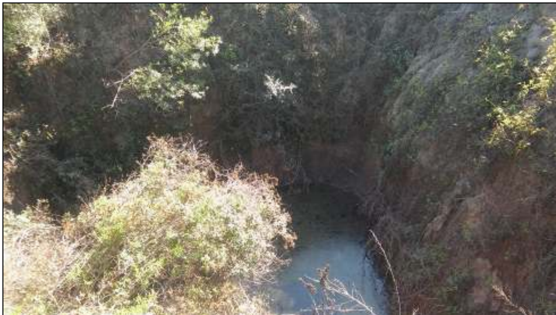
Pozo sin calzar al lado de la represa con NE = 5 m y CE = 0,9 dS/m en superficie.
