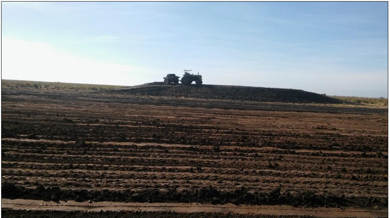
Panorámica de la obra: represa en primer plano y equipo construyendo la pared del tanque.
