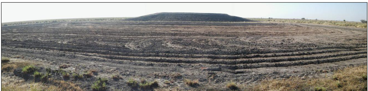
Panorámica de la obra recién terminada: represa en primer plano y tanque de tierra al fondo.
