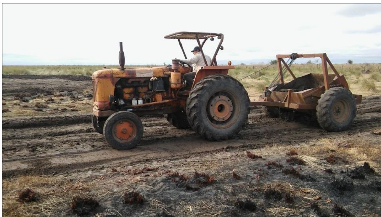
Equipo de tractor de 90 HP con pala mecánica con ubicación lateral de las ruedas, de 3 m 3 de capacidad, ideal para construir la pared del tanque.
