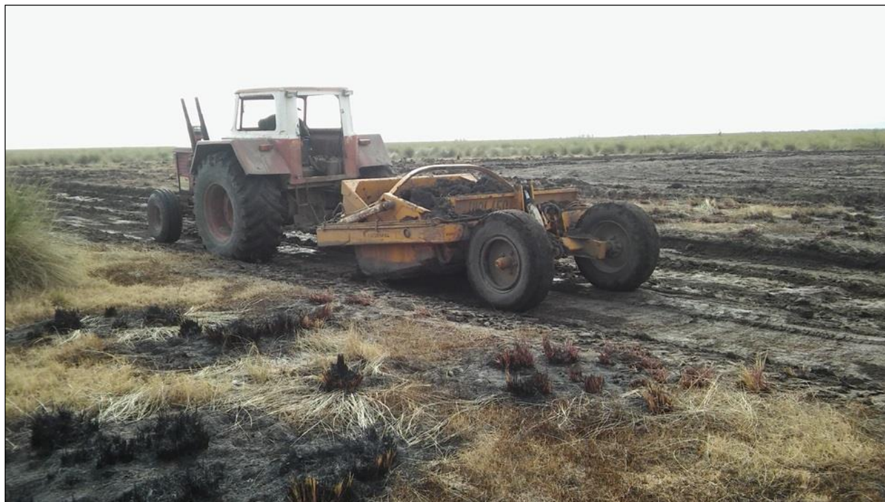
Equipo de tractor de mayor potencia (150 HP), con pala hidráulica de arrastre de 5 m 3 de capacidad, y ruedas ubicadas detrás de la pala.
