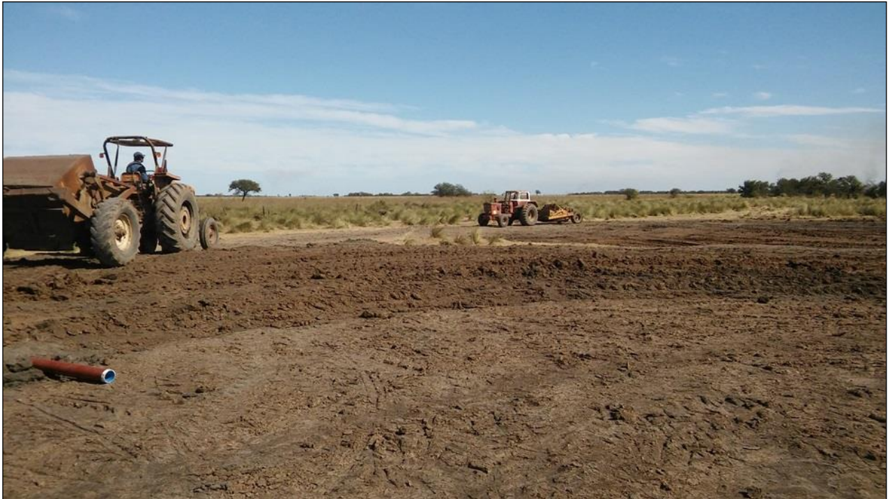
Vista desde adentro del tanque. La salida de la cañería hacia el sur en primer plano.
