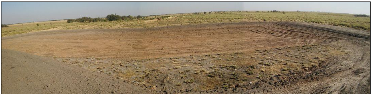
Panorámica de la represa colindante terminada.
