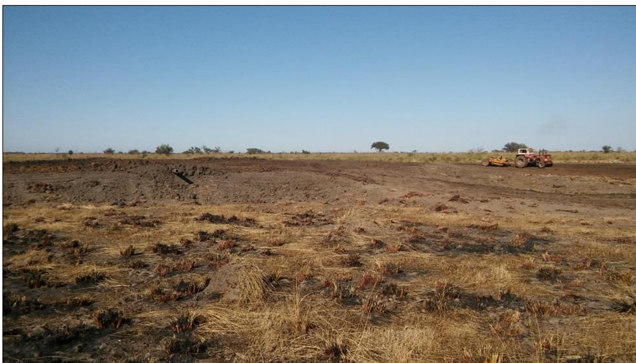
Panorámica de base terminada. Construcción de la pared del tanque de tierra. Se visualiza la cañería de salida hacia el norte.
