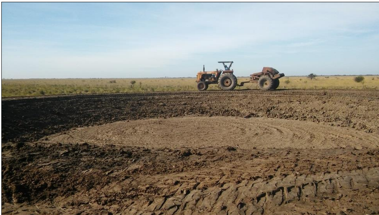
Vista interior del tanque de tierra construyendo la pared con el equipo preparado para poder compactar adecuadamente tanto la pared interior como exterior.
