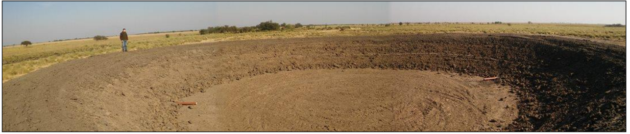
Panorámica del interior del tanque terminado comparado con el Ing. Luciano Sánchez.
