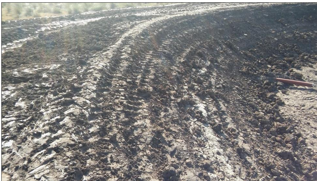
Detalle del talud interior de la pared con la adecuada compactación que provoca el paso de la rueda exterior con la pala de arrastre cargada.
