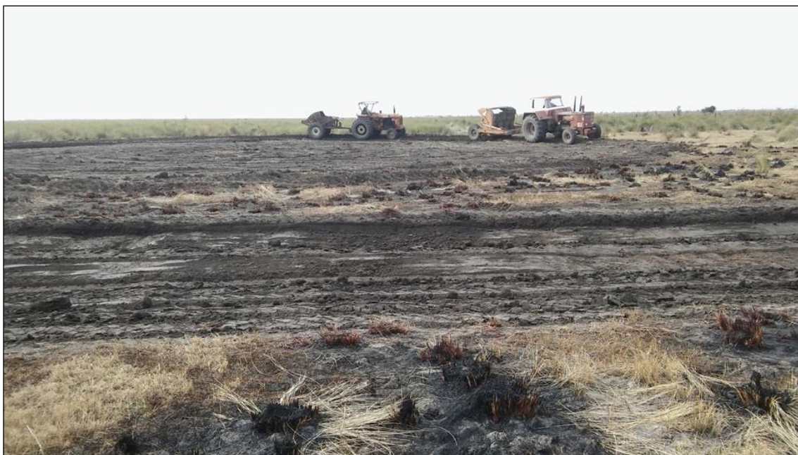
Inicio de la obra con equipos de tractores con palas de arrastre.
