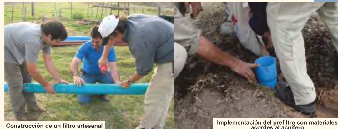
Construcción de un filtro artesanal
