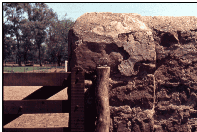
Enganche de tranquera para corrales, cómodo para trabajar montado, instalado en un corral de pirca (Est. Las Rosas, Sampacho).
