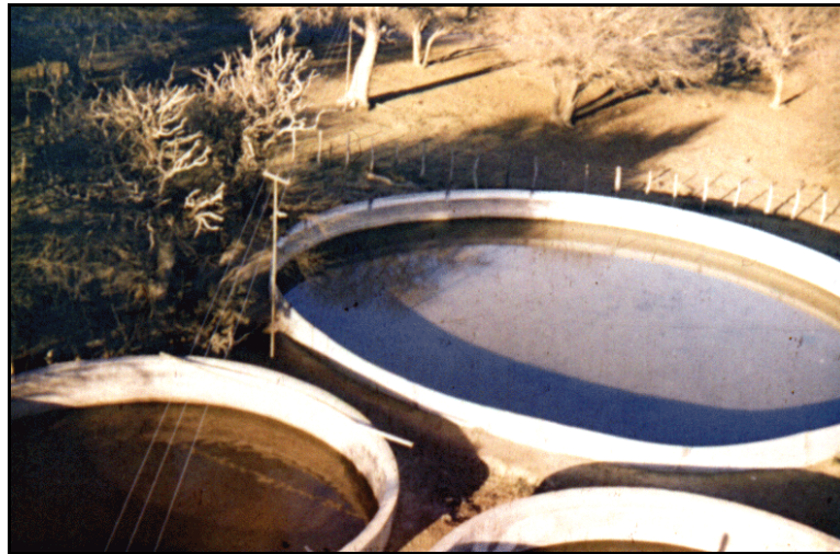
Figura 16.- Tanques para mezcla de agua salina de napa con agua de tajamar (Ing. Luiggi, prov. La Pampa).
