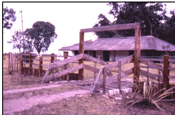
a)-El travesaño sobre el guardaganado es para evitar el paso de vehículos pesados (tractores, camiones) que pueden romperlo.
