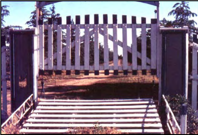
a)-Guardaganado con tranquera automático. Cuando el vehículo presiona el piso, la tranquera se eleva inmediatamente.
