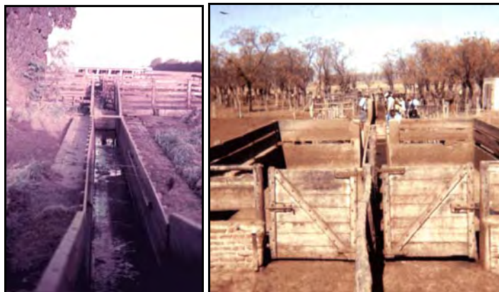
a)-Antiguo baño construido en madera dura; al fondo, los dos corrales del escurridero (Est. La Sofía, Las Vertientes, Córdoba). b)-Escurridero de madera (Est. Las Mercedes, Las Vertientes, Córdoba).
