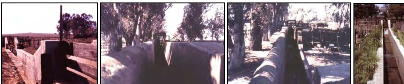
a)-Bañadero de cemento con reborde superior para evitar salpicaduras y pérdidas de líquido en toda su extensión; al fondo el escurridero. b y c)-Antiguo bañadero construido con piedras visto desde el escurridero; no tiene reborde contra salpicaduras (Est. Las Rosas, Sampacho, Córdoba). d)-Bañadero al que por mala construcción fue necesario colocarle travesaños internos por ceder sus paredes.
