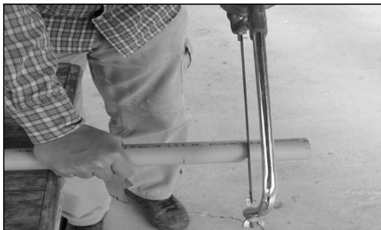
Foto 1. Ranurado del freatómetro en la zona del filtro
