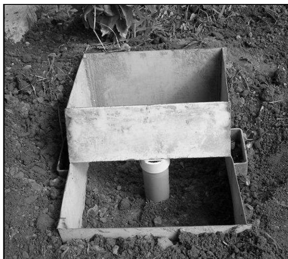
Foto 2. Freatímetro y molde colocado para la base de cemento.
