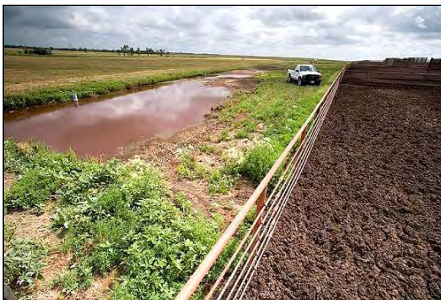
Foto 1: Agua colectada sobre la izquierda en una laguna de separación de sólidos en el extremo inferior del corral de engorde (a la derecha) después de una lluvia. Después de disolver los sólidos, el agua de la laguna será distribuida en toda la zona de tratamiento vegetativo.
