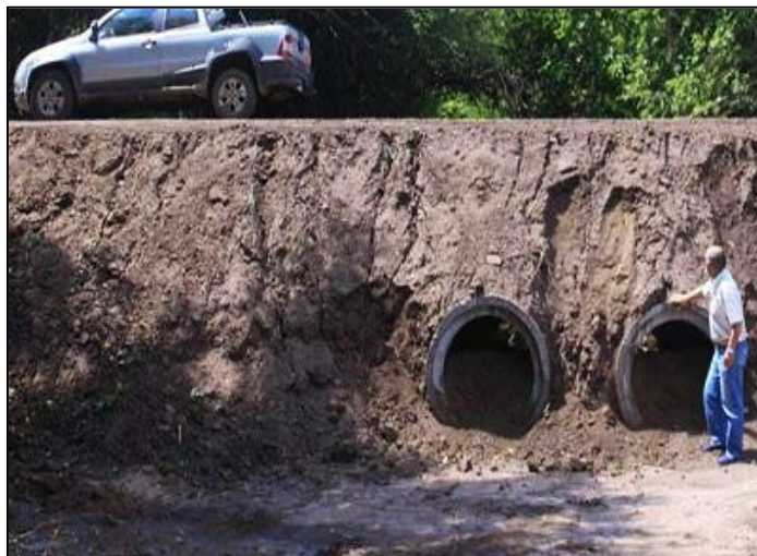
Microdiques para contener crecidas en Córdoba.
