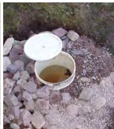
Captación de un manantial realizada con un balde de 20 litros perforado en los laterales, y enterrado. Se observa además la salida a la conducción, también se lo rellena con ripio para mejorar la captación. Maimará.
