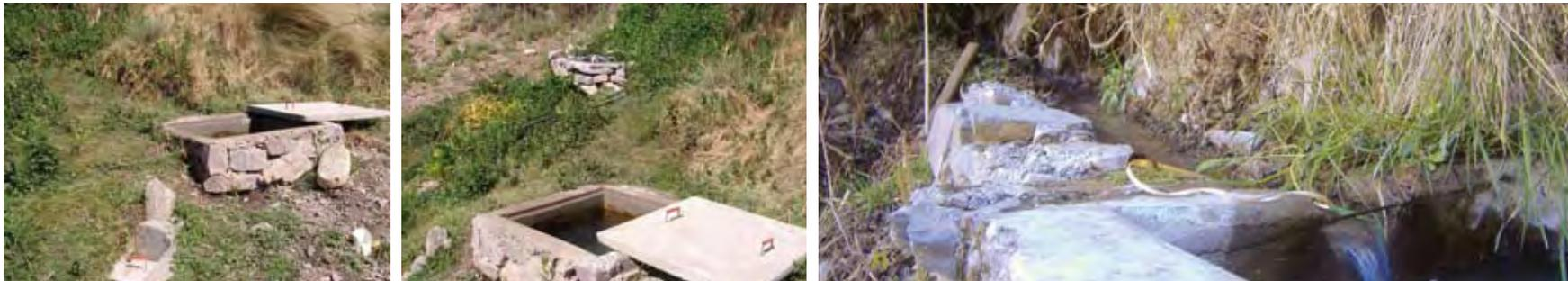
Se observa la cámara de carga separada de la captación y cámara de carga sobre la captación.
