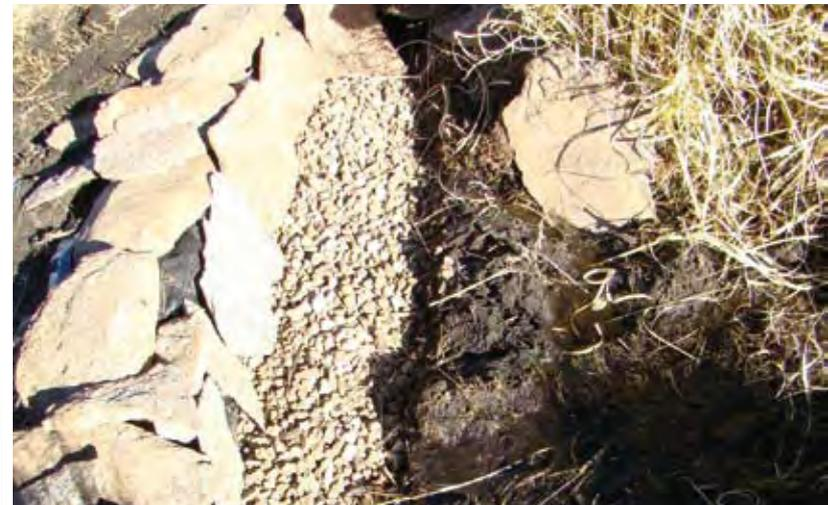
Se observa un manantial de ladera difuso, la excavación para la instalación del caño filtrante, que luego es cubierto por ripio, gravilla y piedra.
