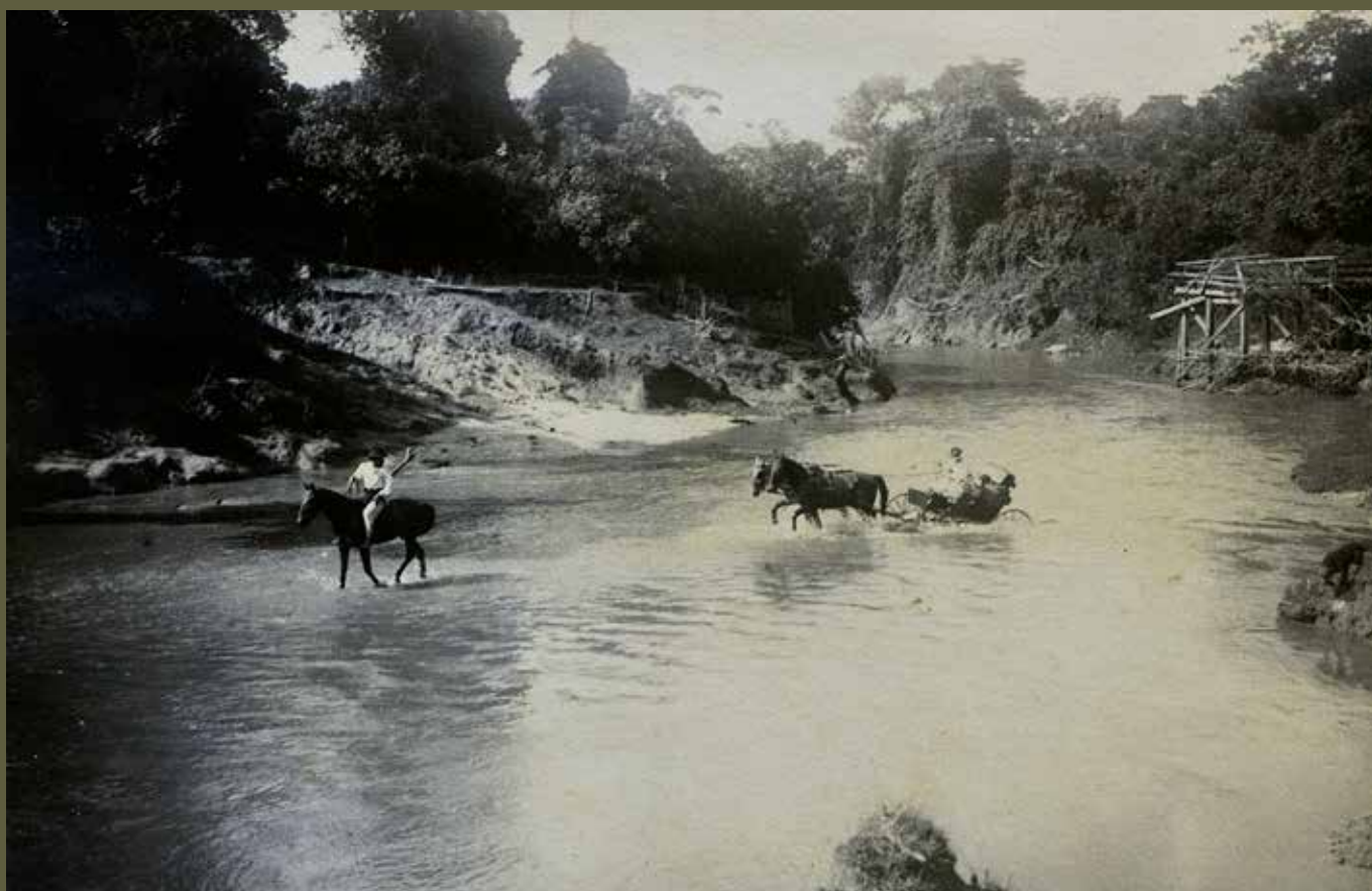
El paso del río Lapas, con un puente destruido por una gran creciente. Tierras de Société Foncière du Paraguay . Puerto Foncière. Concepción, Paraguay. 1922. Col. Hrisuk.
