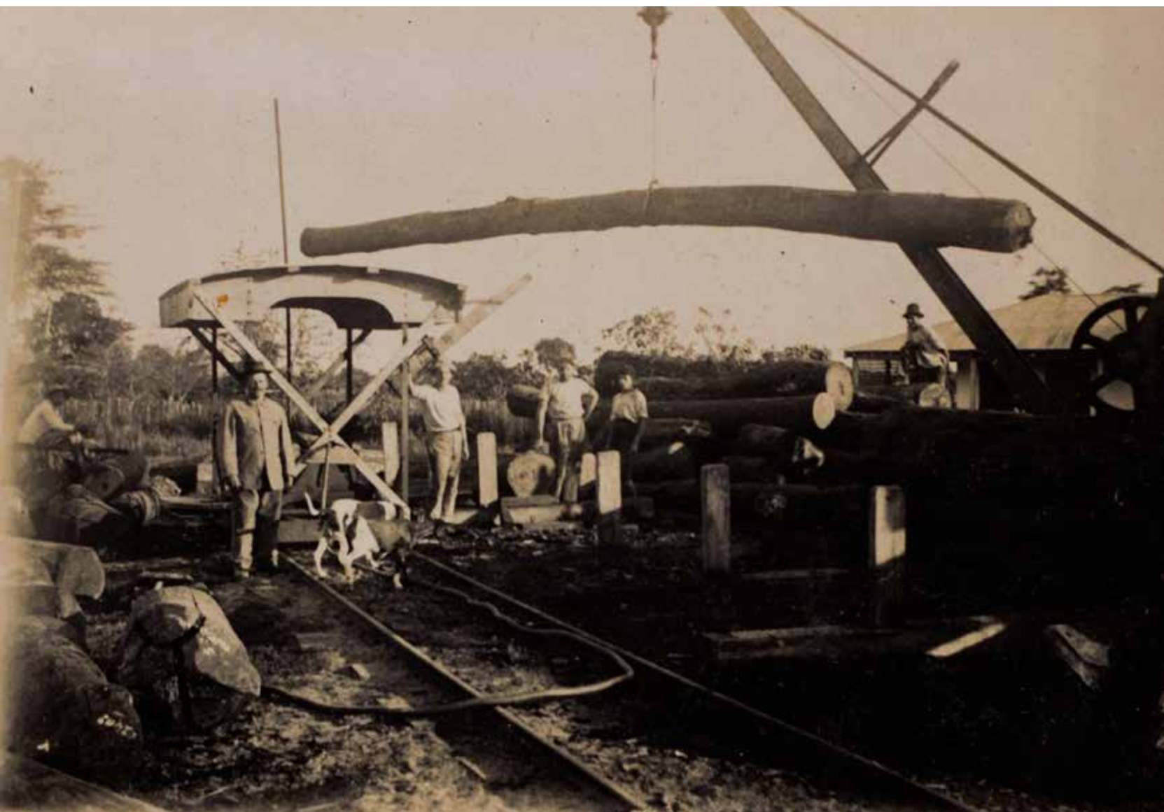
La maquinaria a vapor para despuntar y trocear la madera. Puerto Ybapobó. San Pedro. Paraguay. 1922. Col. Hrisuk.
