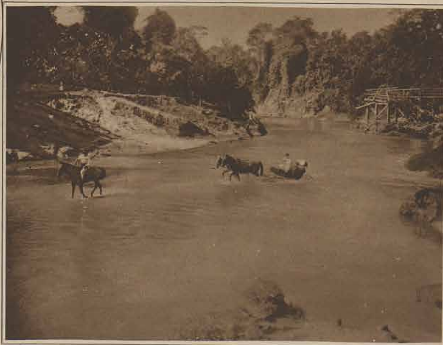
Passage d'une rivière. A l'arrière-plan, les vestiges d'un pont emporté par une crue.
