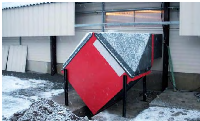
Recuperador de calor trabajando en pleno invierno.
