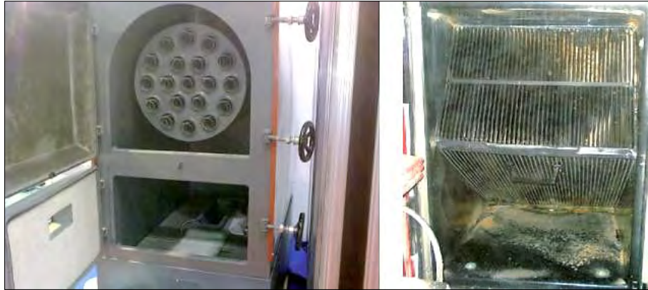
Cámaras de combustión y de intercambio en una caldera de biomasa moderna (izquierda) y sistema de entrada de aire por ático con entrada de aire lateral.
