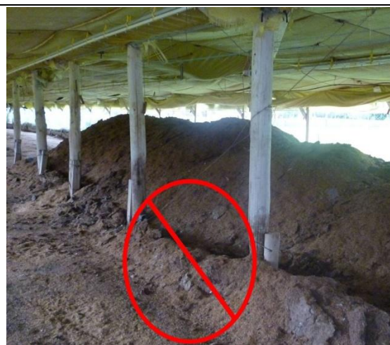
Foto 6- Apilado incorrecto: parte del material fuera de la pila.
