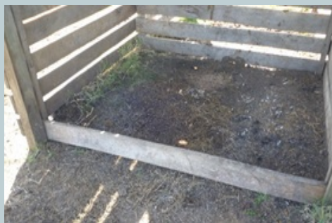
Foto 4: colocación de tabla en lado desmontable
