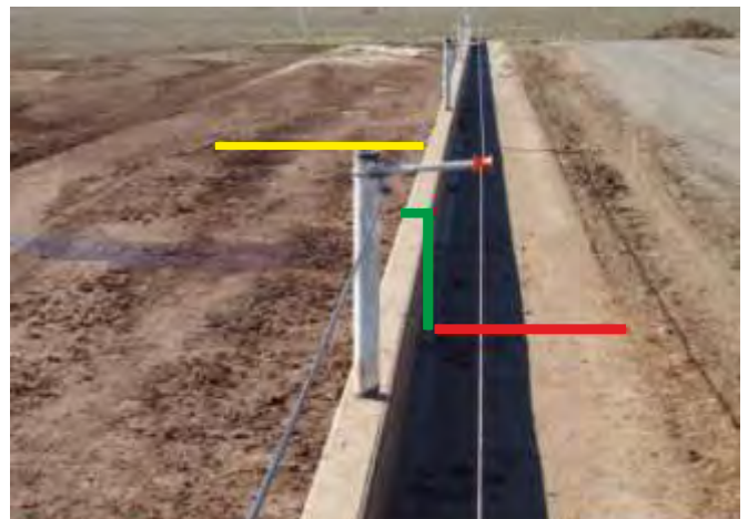
Foto 1: Corral seco. Línea amarilla: Pista de cemento donde las vacas se paran para comer. Línea verde: cordón de cemento. Línea roja: pavimento donde se deposita la TMR (comedero).
