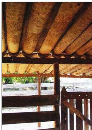
Los equipos se entregaron con la condición de instalarlos en un tinglado con las comodidades mínimas para el ordeñador. Buena parte de los mismos se construyeron utilizando materiales locales, como este techo de palo de palma, que abunda en la zona.
