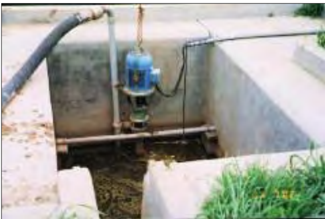
Figura 1. Depósito temporario de efluentes;
