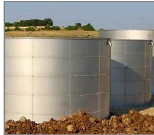
Tanques de homogenización
