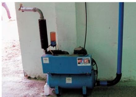
Detalle de la bomba de vacío.
