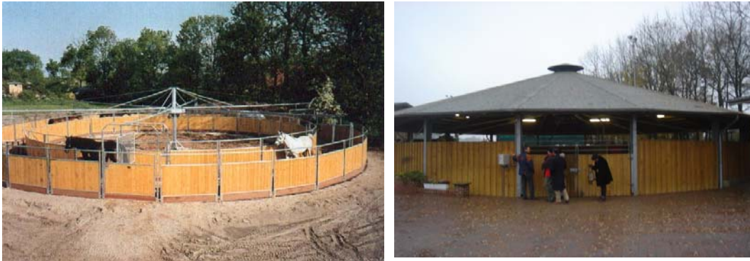
Figura 6: Izquierda noria descubierta y derecha noria cubierta
