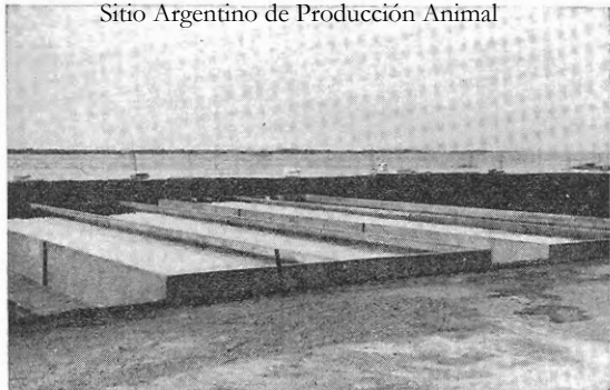
Fig. 3. — Tanques exteriores de hormigón armado donde se mantienen los peces jóvenes del Paraná hasta su transporte en camión para sembrar los ríos.
