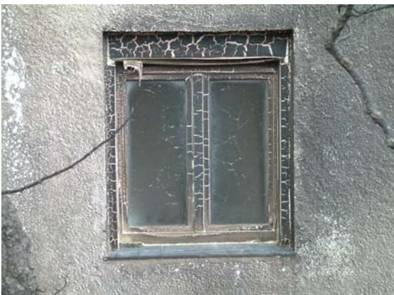
**Fig 15.** Efecto del fuego sobre vidrios y cerramientos de las aberturas exteriores.
