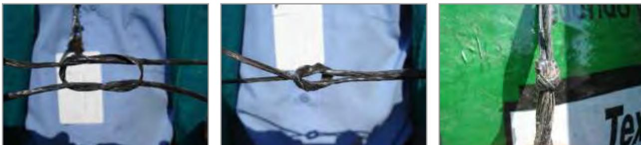
**Figura 4.67.** Secuencia de formación del nudo plano que facilita el pasaje del hilo.
