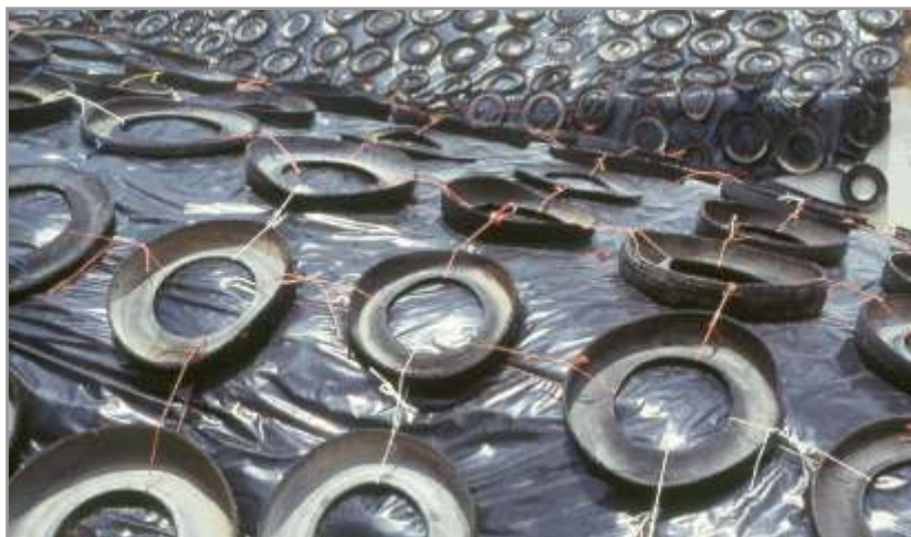
Figura 6.39. Cubiertas de auto cortadas al medio y debidamente colocadas y unidas entre sí.
