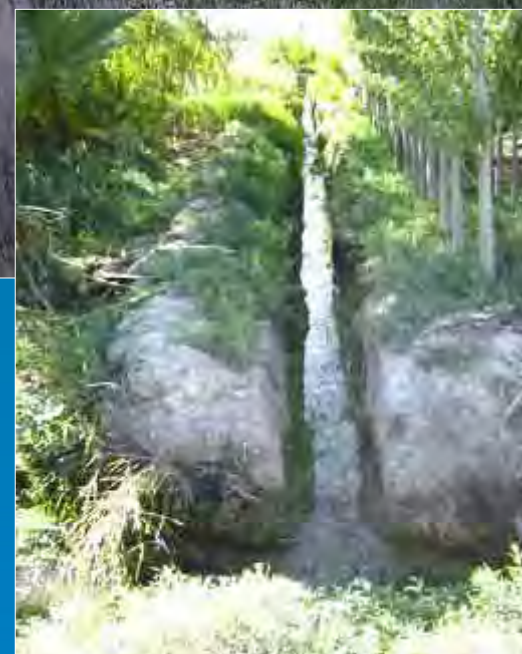
Construcción de drenes
